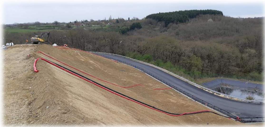
Mise en place de la terre végétale
