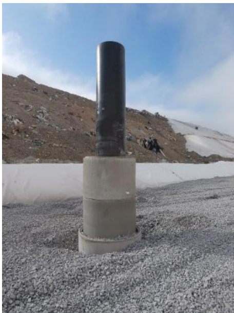
Mise en œuvre des matériaux drainants et installation du puits lixiviats le 06 décembre
