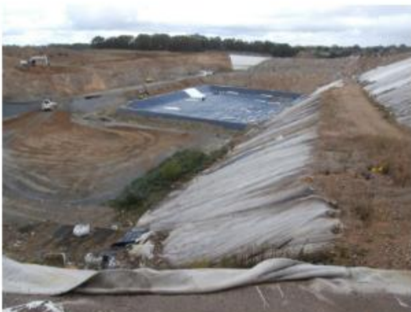
Mise en œuvre du DEG dans le fond du casier 3.3
