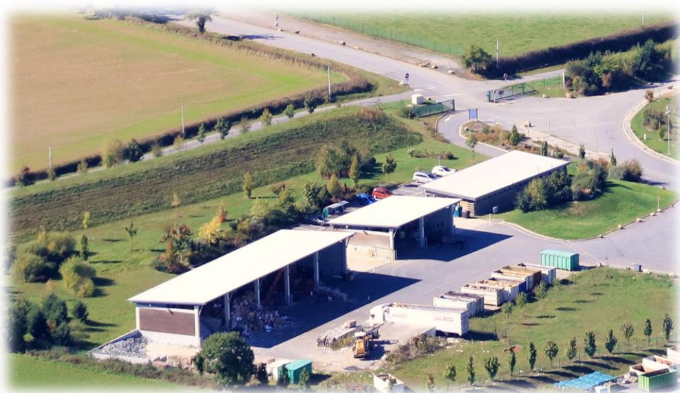
Bâtiment de transfert des cartons et plâtre
