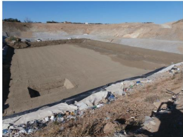
Fin de réalisation de la BSP du casier 3.3
