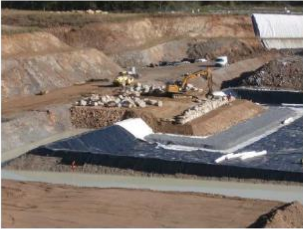
Réalisation du quai de déchargement du casier 3.3
