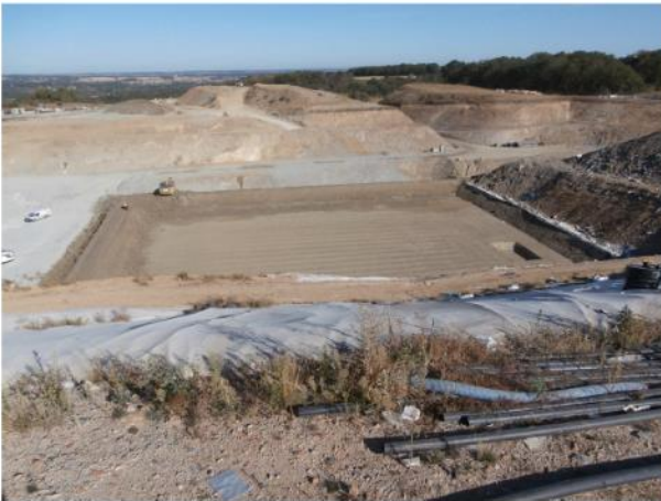
Fin de réalisation de la BSP du casier 3.3
