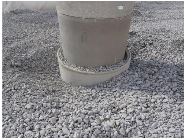
Mise en œuvre des matériaux drainants et installation du puits lixiviats le 06 décembre
