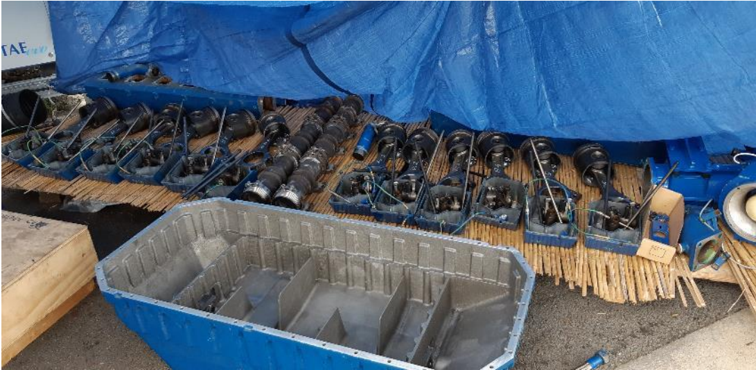
Démontage des 12 pistons
