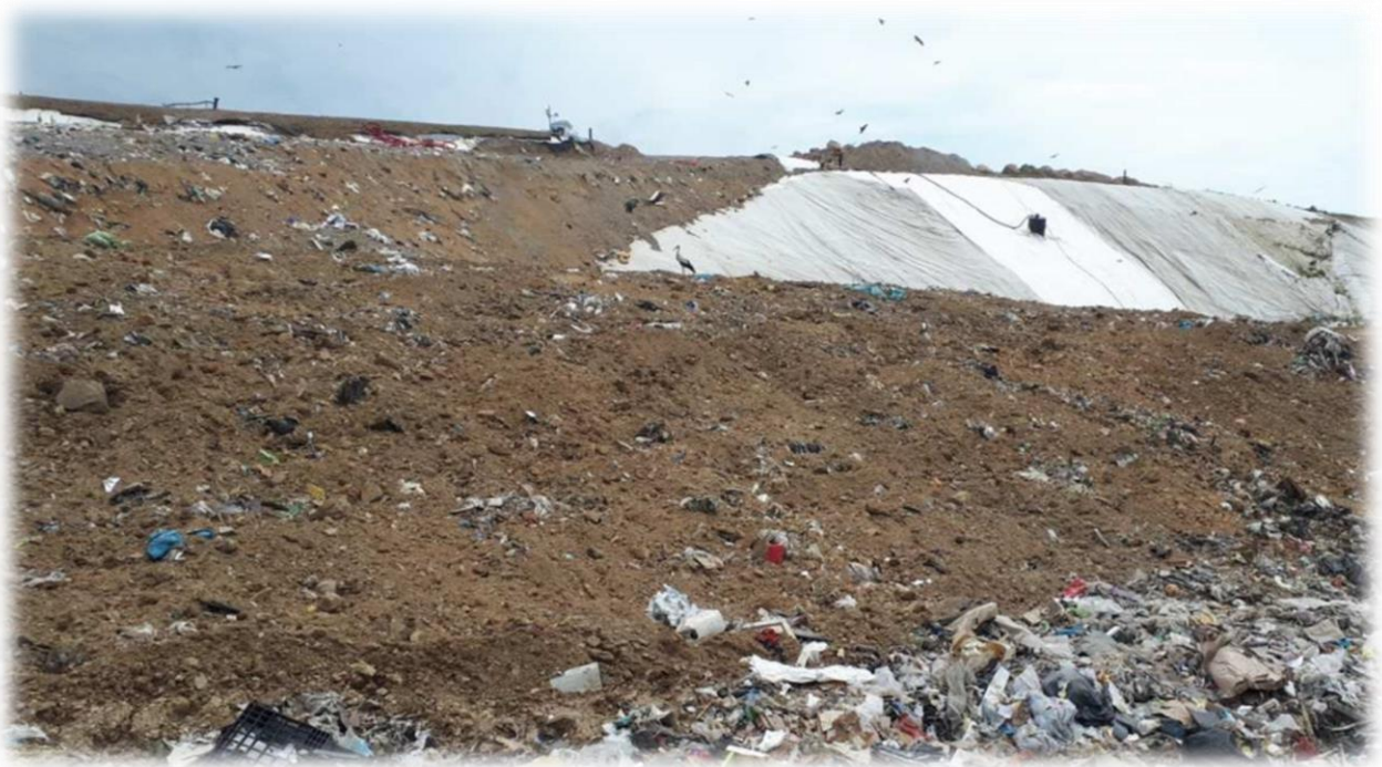
Couverture en terre de la zone incendiée
