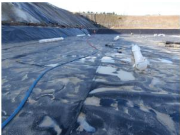
Mise en œuvre du DEG dans le fond du casier 3.3
