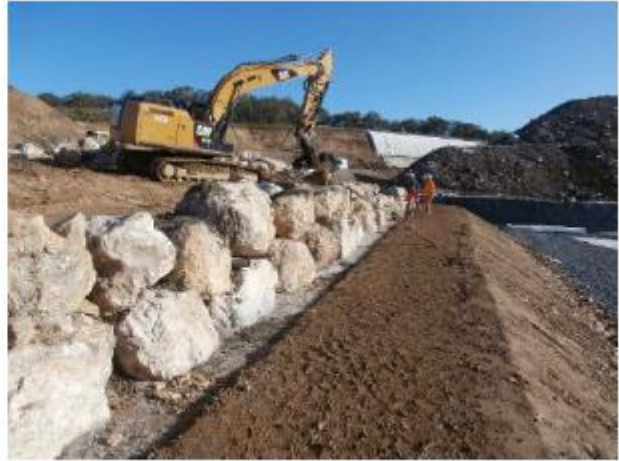
Réalisation du quai de déchargement du casier 3.3
