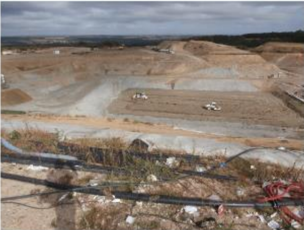
Réalisation de la BSP du casier 3.3
